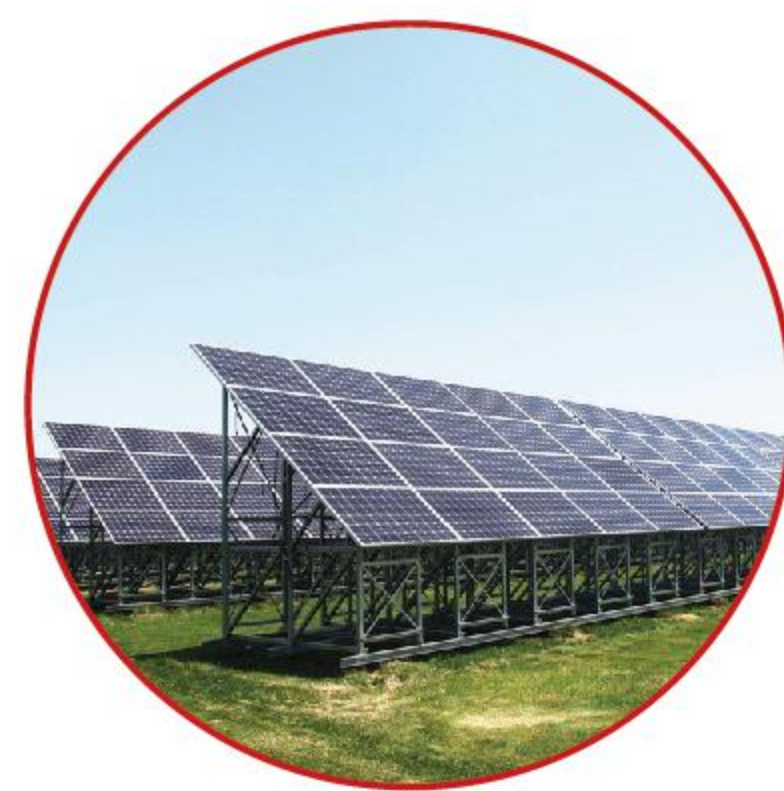
大型地面电站
